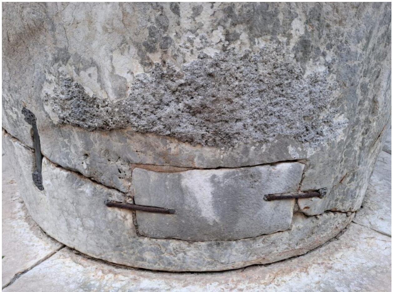
Mended Well (Venice 2024) Detailaufnahme © Hendrik Rungelrath
