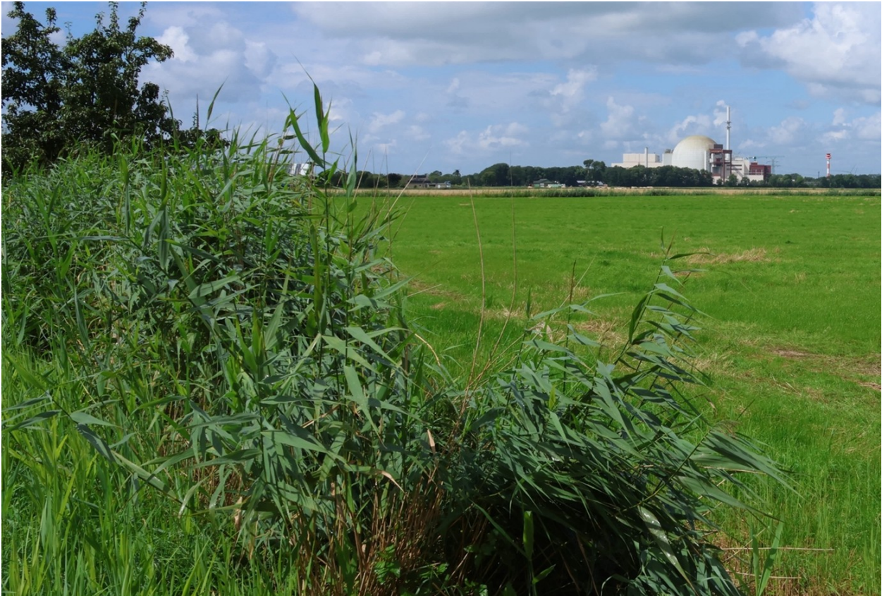
Blick auf das Kernkraftwerk Brokdorf von der Straße Osterende (Landkreis Steinburg), August 2025 © Rudolf Renner
