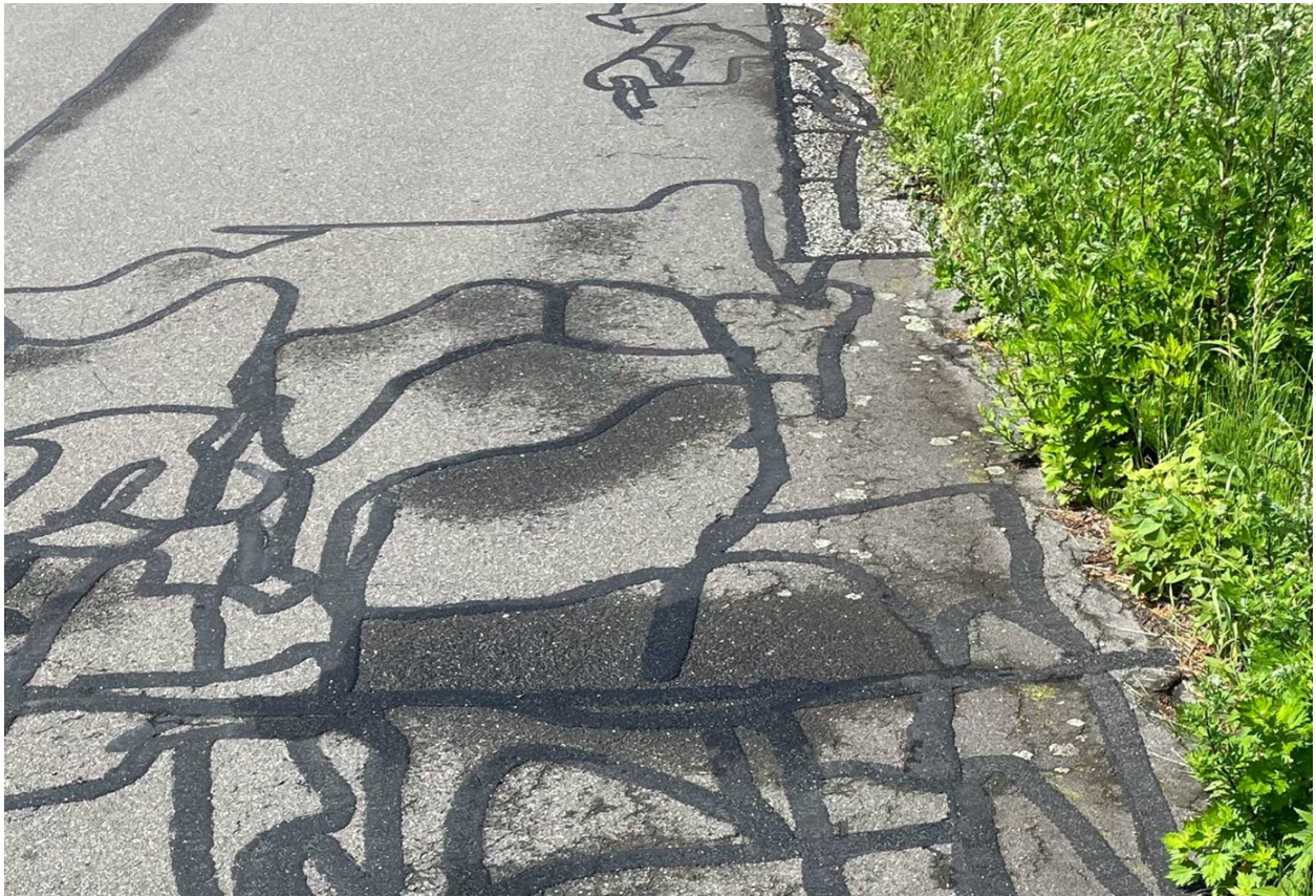
Bundesstraße 431, Abschnitt zwischen Brokdorf und Sankt Margarethen, August 2025
